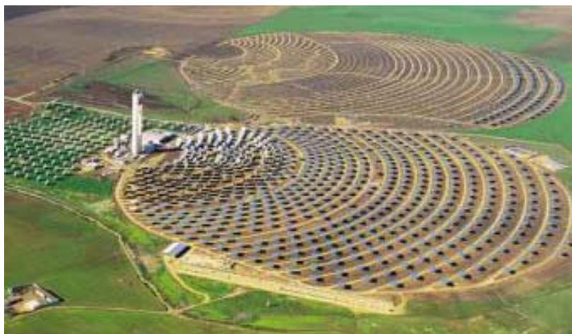
**Figure 1.2. . Vue aérienne de la centrale PS10, avec au fond le champ d'héliostats de PS20 en construction**
